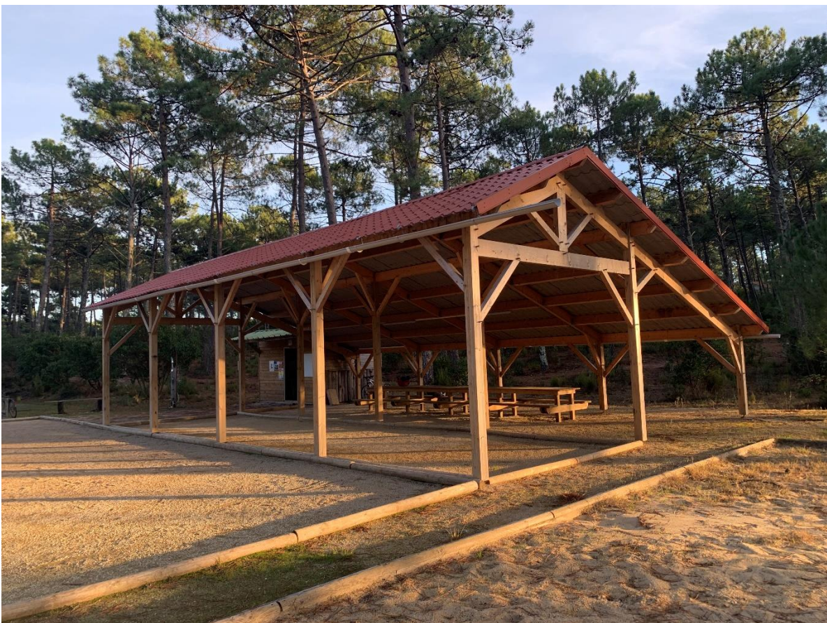
Abri petanque met dakgoten, elektriciteit, water, rondins en een eethoek voor de spelers.
