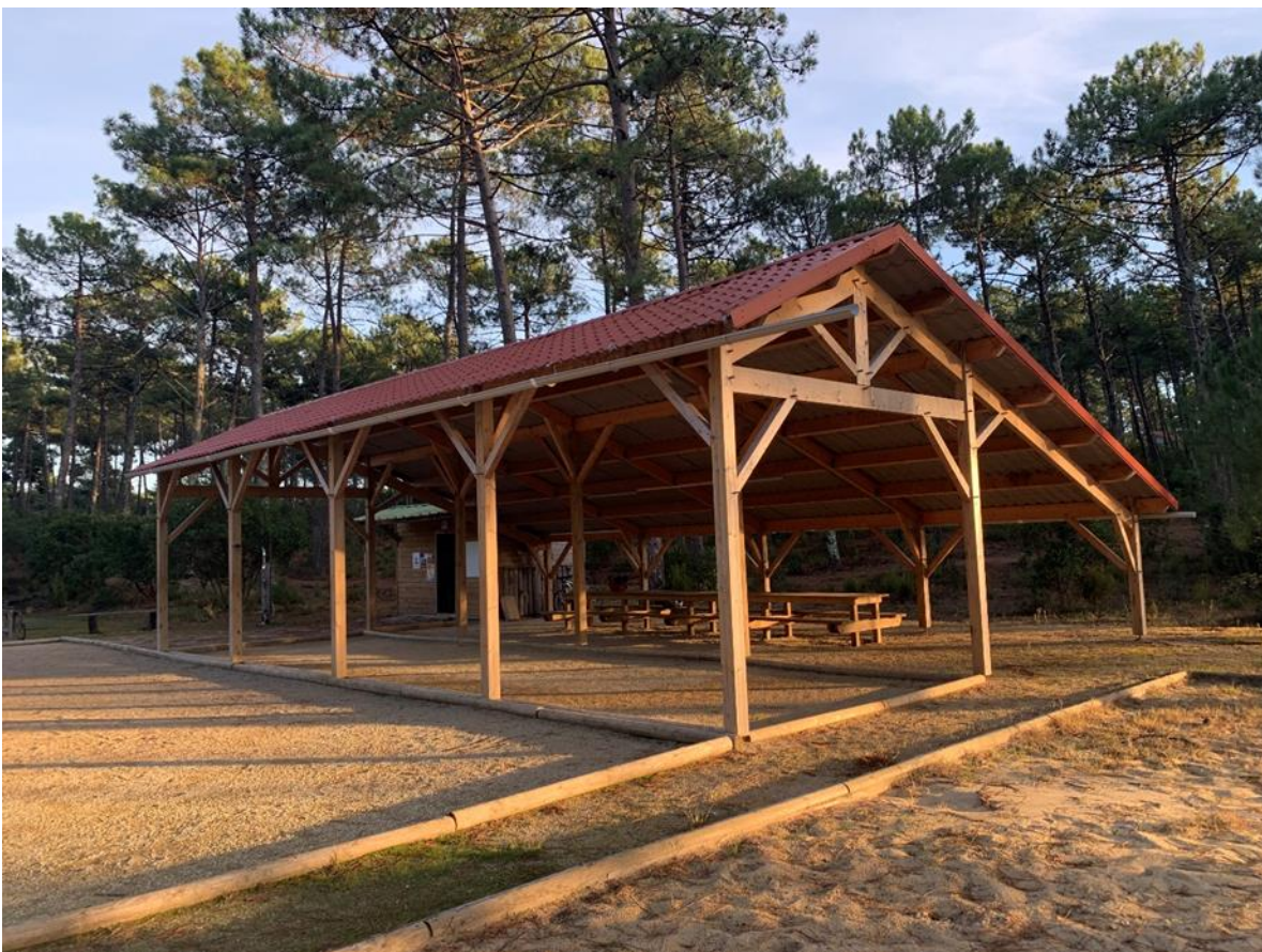
Petanque-Unterstand mit Regenrinnen, Strom und Wasser, Rundhölzern und Picknicktischen für ein fröhliches Zusammensein.
