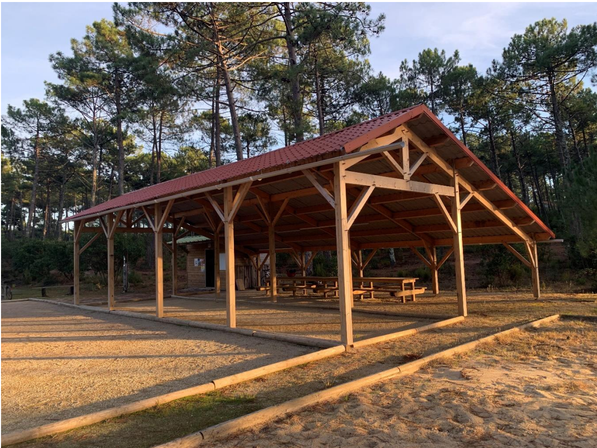
Abri pétanque avec gouttières, électricité, point d'eau, rondins et coin repas pour se réunir ensemble.
